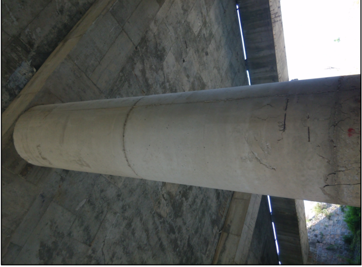
左2-2墩混凝土开裂、脱落且钢筋外露且锈蚀严重
