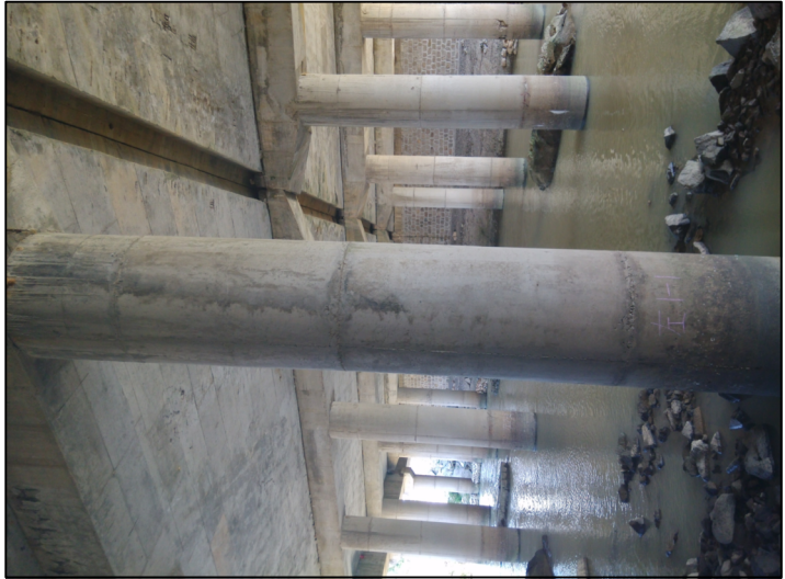
左1-1墩表面混凝土脱落
