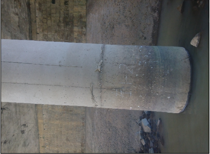
左1-2墩存在明显纵向裂缝
