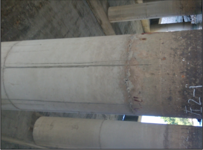
左2-1墩表面混凝土存在明显剥落
