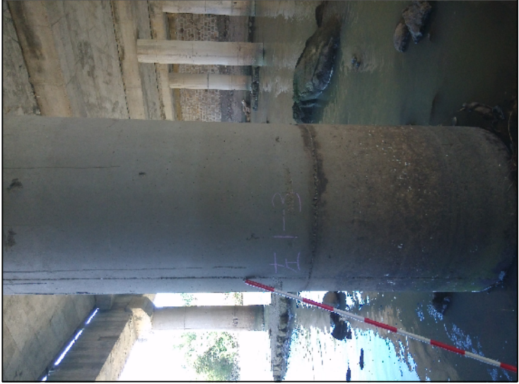
左1-3墩表面混凝土存在明显腐蚀
