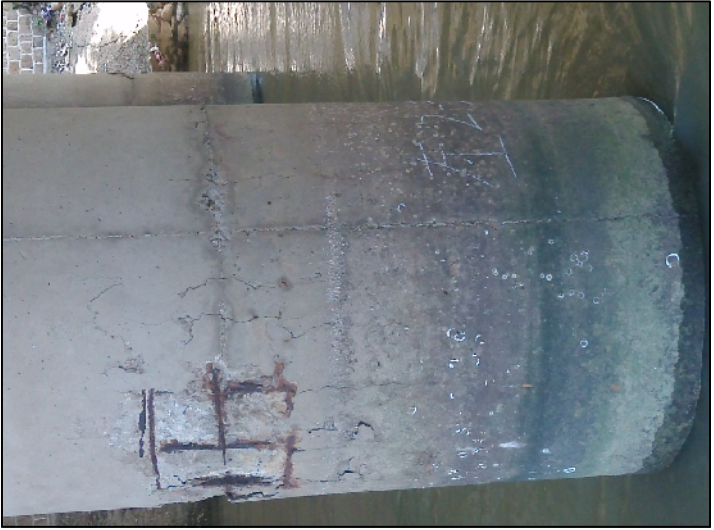
左2-3墩混凝土开裂、脱落且钢筋外露且锈蚀严重
