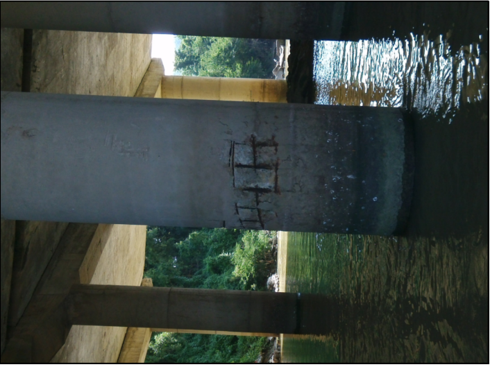
左2-4墩混凝土开裂、脱落且钢筋外露且锈蚀严重
