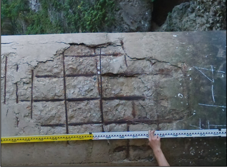
左1-4墩混凝土严重开裂、脱落且钢筋外露且锈蚀严重
